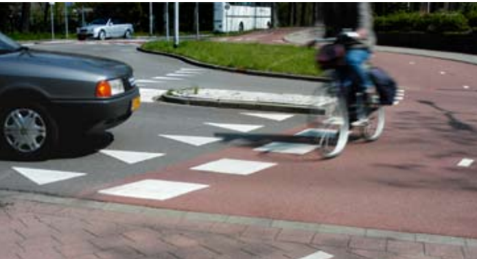
Fietsoversteekplaats met blokstrepen: de haaiantanden regelen de voorrang.
